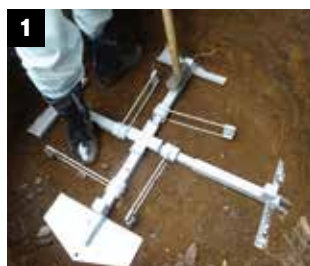
アンカー打設。
