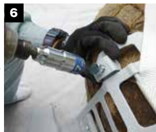
肩バットの位置を固定し、 根鉢ロックピン取り付け。
