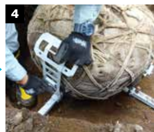
肩バット・ベルト設置。
