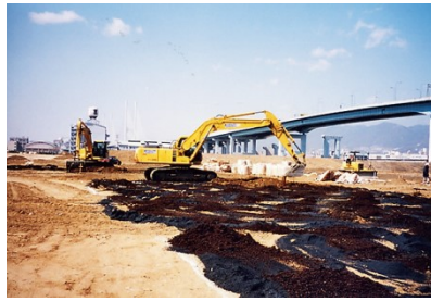
施工中の様子
