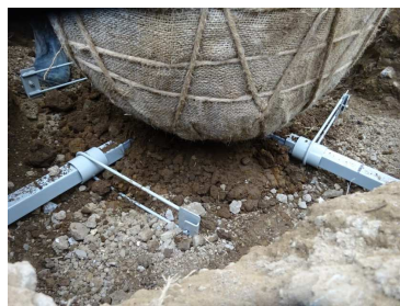
樹木立て込み後
