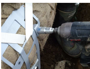
ボルトで締め込み
