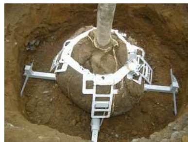
ベルト締め込み後の状況
