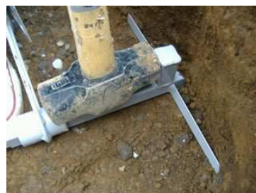
抵抗板を全て打ち込む
