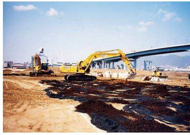
施工中の様子
