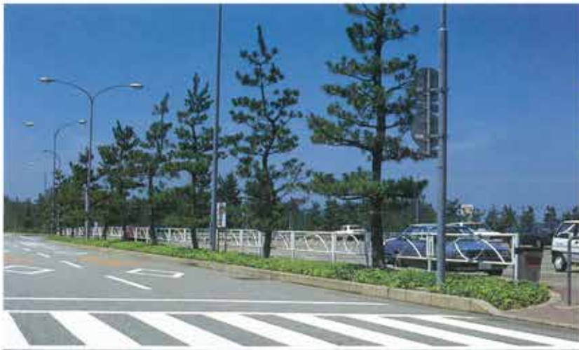
石川市 小坂2丁目植栽工事
