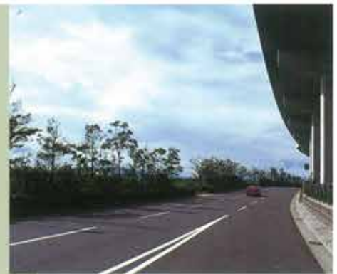
大阪府 中央環状線街路植栽工事
