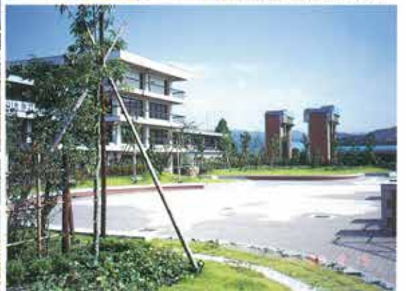
国土交通省・琵琶湖工事事務所植栽工事
