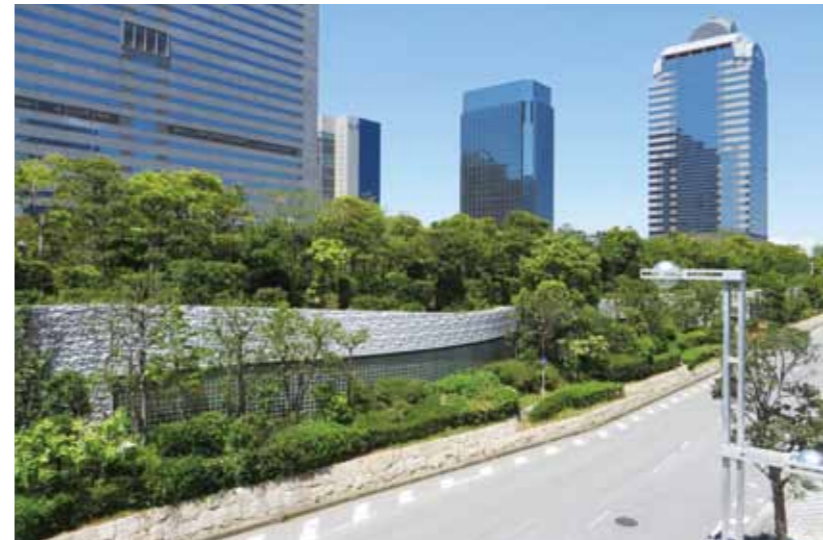
千葉県 幕張メッセモール 施工26年後の状況。樹勢は良好。
