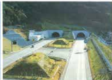
日本道路公団 山陽自動車道植栽工事
