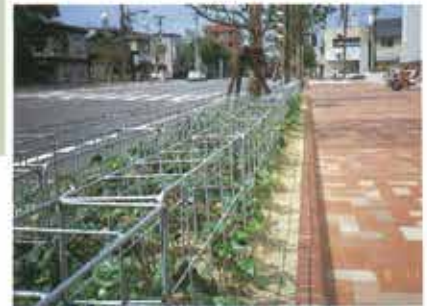
北九州市 若松区役所前植栽工事
