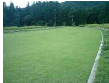
施工後2年の状況。
