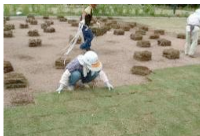
図 7 転圧面に直接芝生を貼る。
