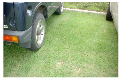
図 8 施工 1 年後の状態、タイヤによる擦り切れは見られるが、生育は良好。
