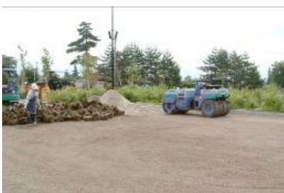
図 6 マカダムローラで十分転圧する。
